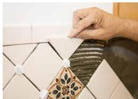
1. Applicazione di ISOLCOLL B40 S1 QUICK mediante spatola dentata
